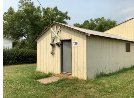
Figure 2.8: Mini Arena Exterior
